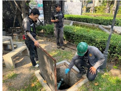
จุดที่ 3 บริเวณบ่อพักน้ำสุดท้ายก่อนระบายออกท่อสาธารณะของอาคาร
